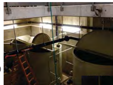
Fig. 5: Vue de l'intérieur du réacteur Fenton pendant l'oxydation
