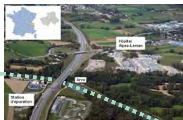
Station d'épuration de Bellecombe
